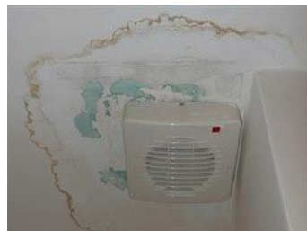
Ventilátorem v podhledu WC zatéká.
