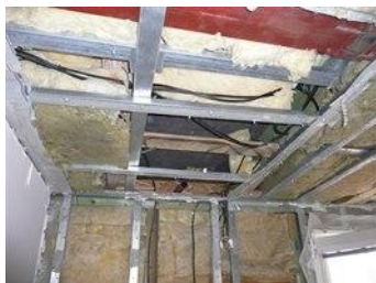
Stav při otevření pohledu. Ocelový nosník nemá izolaci, navíc trámy omezují výšku izolace.
