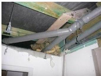
Stav při otevření podhledu. Odvětrávací potrubí je bez izolace, navíc pohled netěsní.
