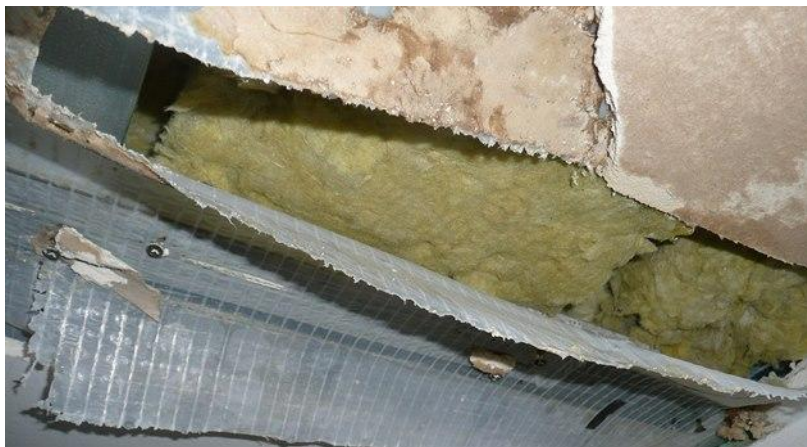
Stav při otevření konstrukce. Izolace podhledu je mokrá. | foto: Bytecheck
